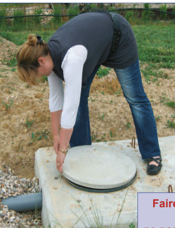
Contrôle d'une installation.
